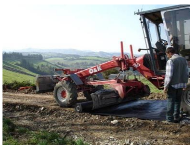
Pose du géotextile
