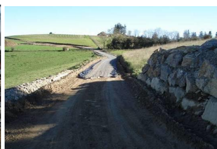
Mise en place du gravier
